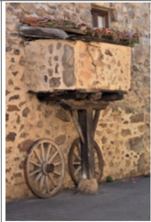
Detalle de hornera en fachada oeste
