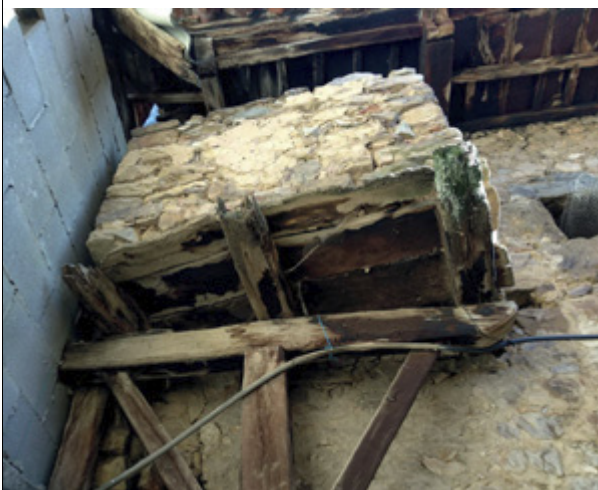
Vista de detalle del soporte de madera de la hornera
