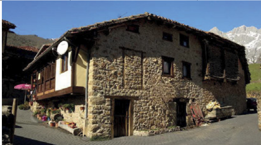
Vista sudeste de conjunto
