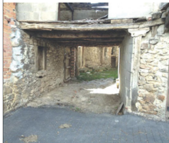
Alzado norte (detalle, planta baja con dos huecos formalizados con madera)
