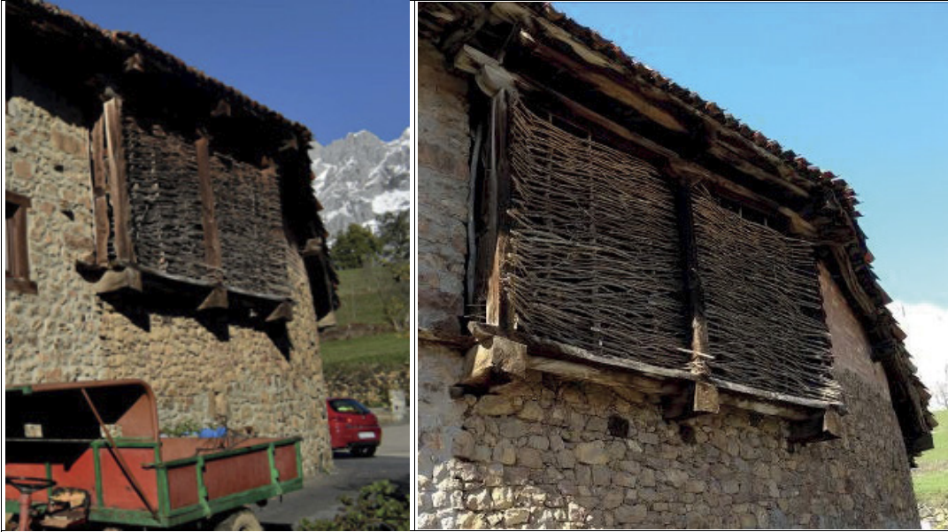
Fachada este con sieto volado
