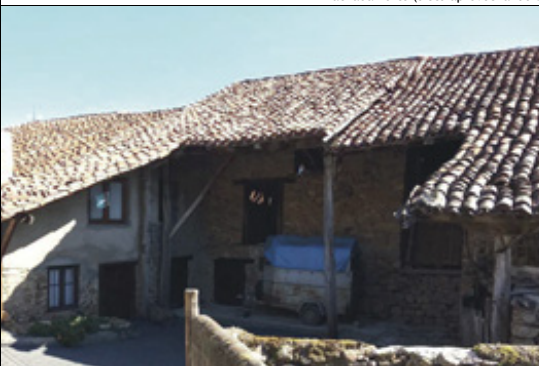
Fachada oeste (conjunto de manzana)
