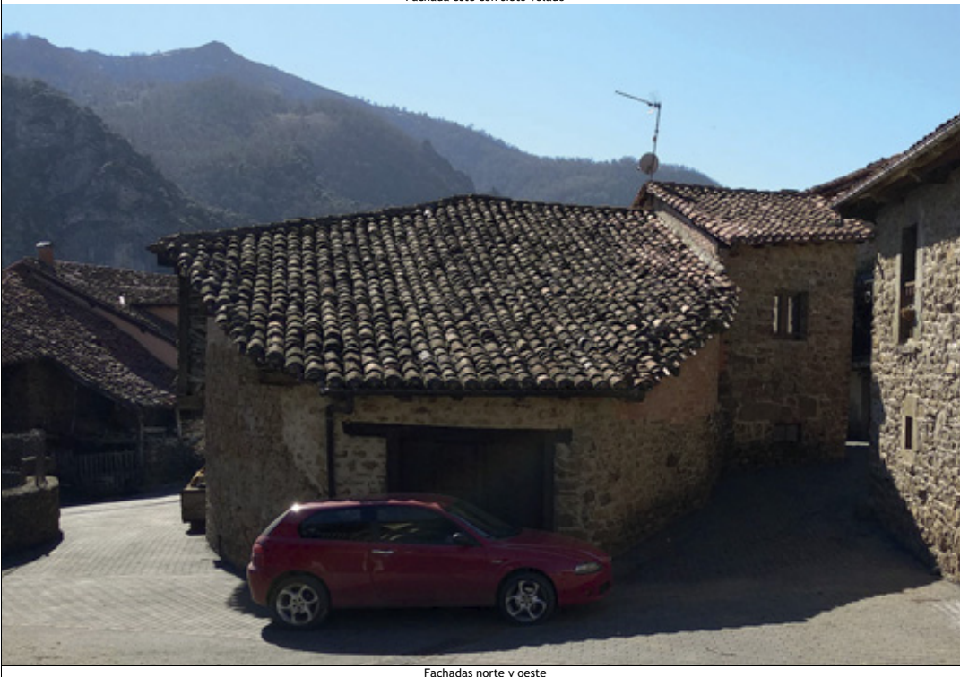
Fachadas norte y oeste
