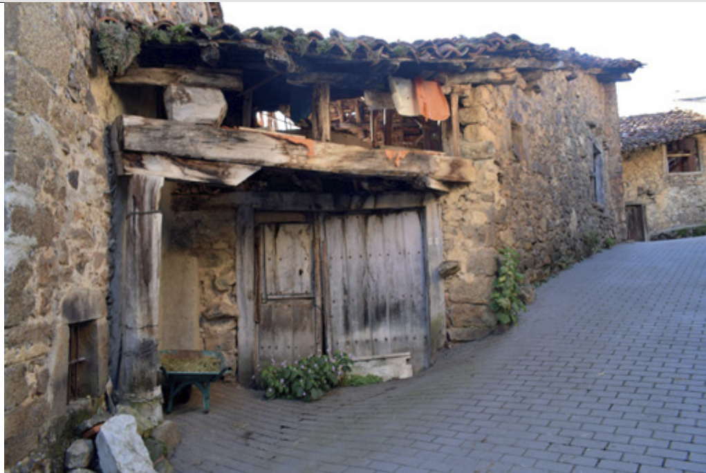
Acceso y muro norte
