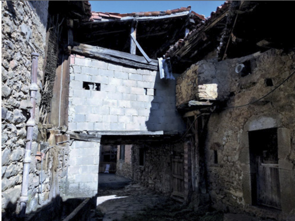
Fachada interior al callejón (en bloque de hormigón, el cierre del anexo agropecuario, y a la derecha, con la hornera, la fachada interior de la vivienda)
