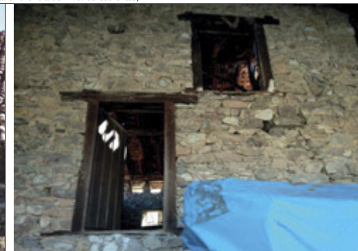
Fachada oeste (Detalle de dos de los vanos)
