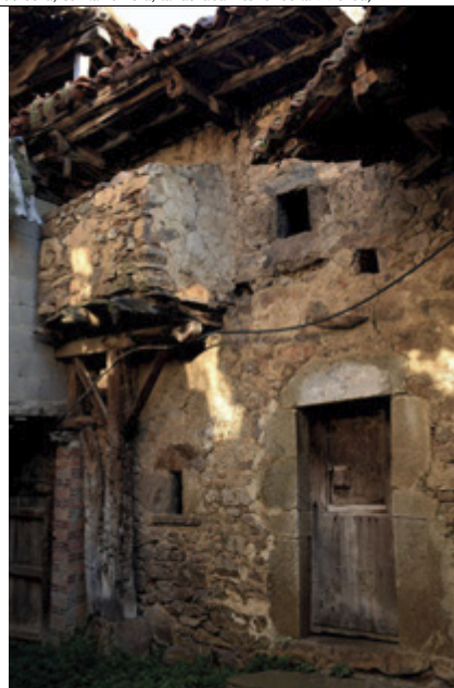
Fachada oeste de la vivienda (callejón interior) con detalle de la hornera
