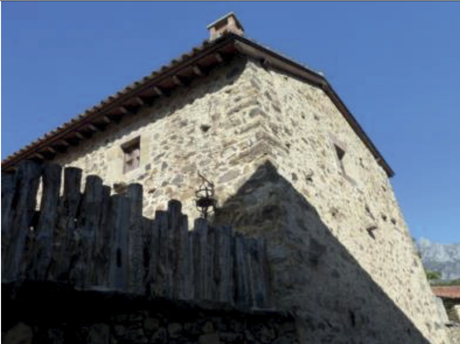
Vista sudeste de la edificación
