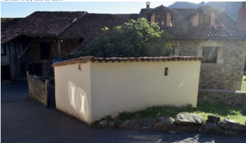
Fachadas sur y oeste del caseto
