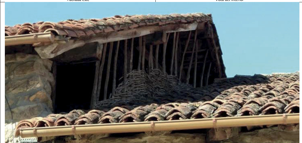
Fachada norte (sieto aprovechando la diferencia de nivel de cubiertas)
