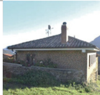
Fachada oeste / sur
