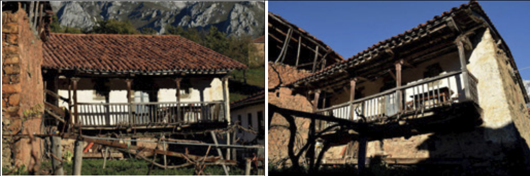
Fachada sur (hacia la parcela)
