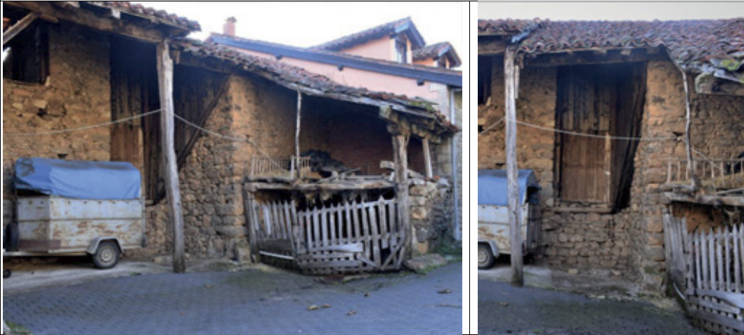
Fachada oeste (detalle de hueco)
