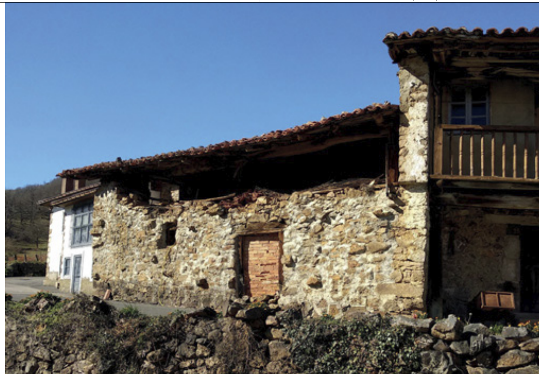
Fachada este (vista general)
