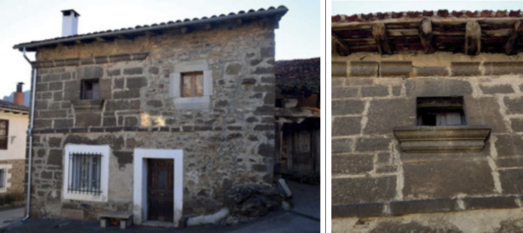
Fachada norte (y detalle de la ventana con sillar labrado)
